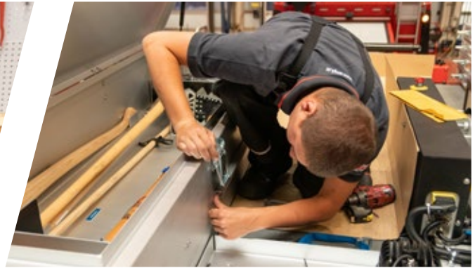
Instandsetzung von einem Dachkasten
