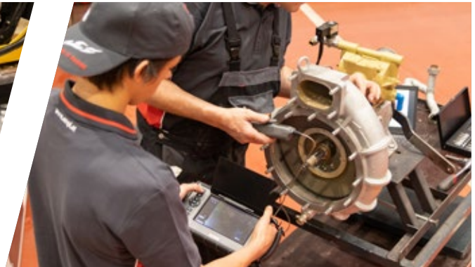
Inspektion einer Pumpe auf Beschädigungen mittels Kamera
