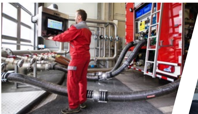
Pumpenprüfstand Pump test stand
