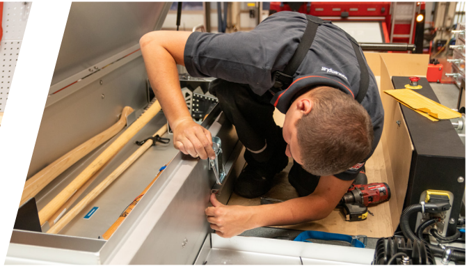
Instandsetzung von einem Dachkasten
