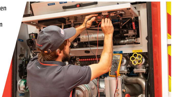
Fehlersuche am Bedienerpult der Einbaupumpe
